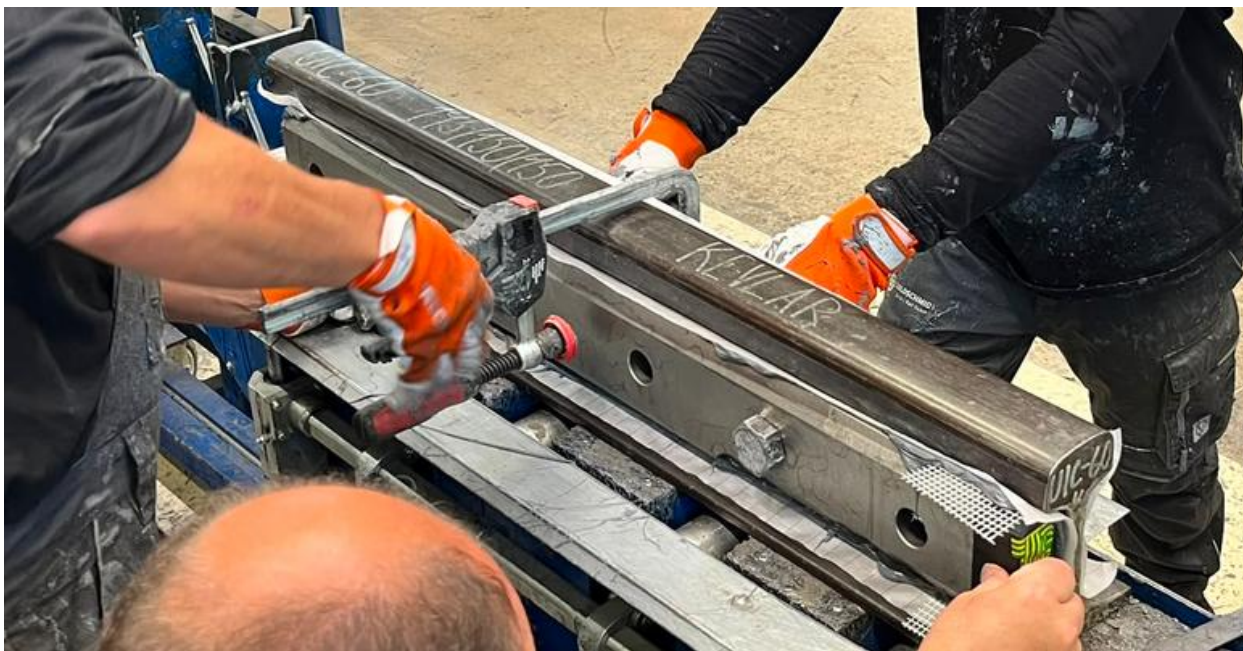
Obr. 6: Montáž spojky s lepidlem a izolačními vrstvami
