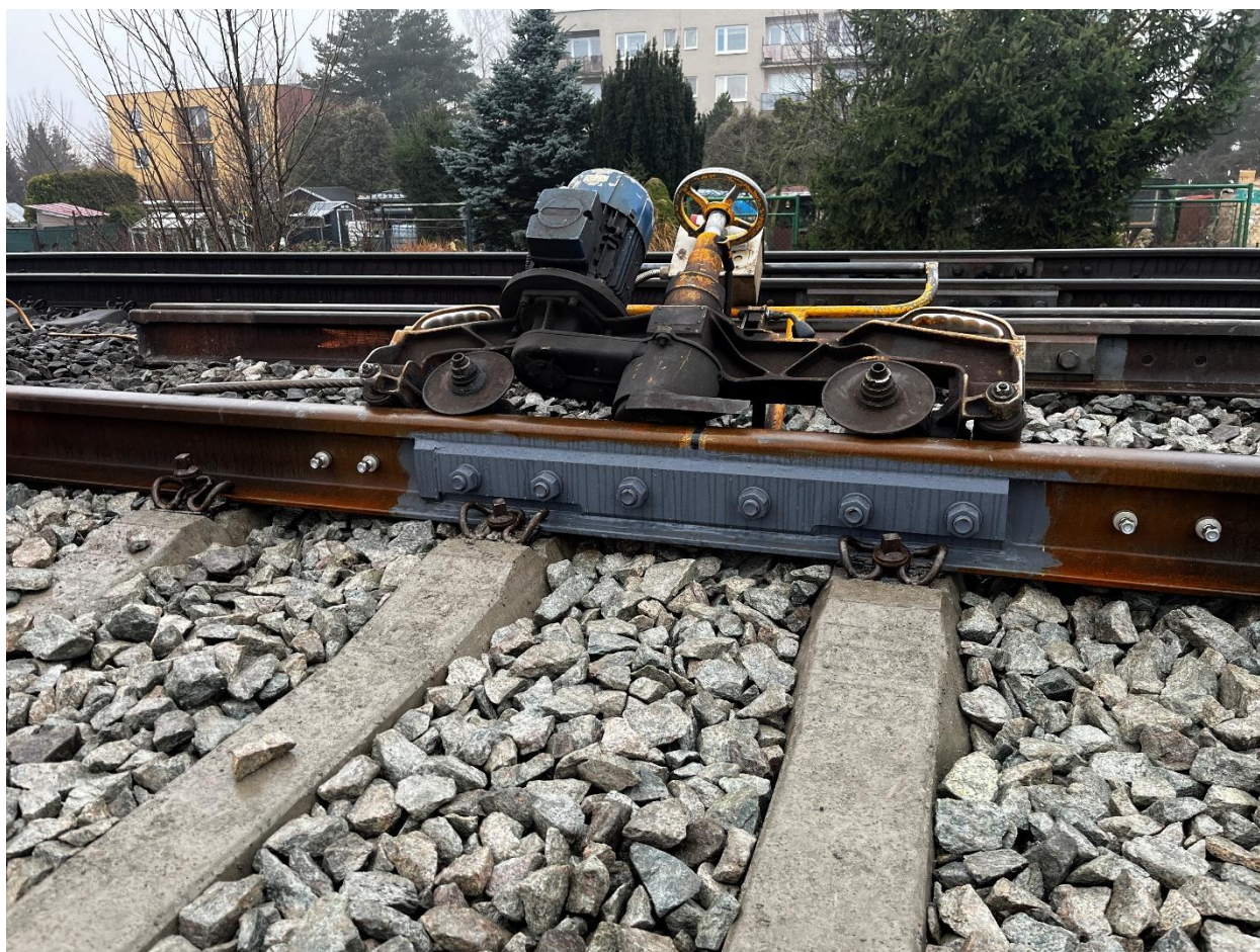
Obr. 7: Finální úprava povrchu
