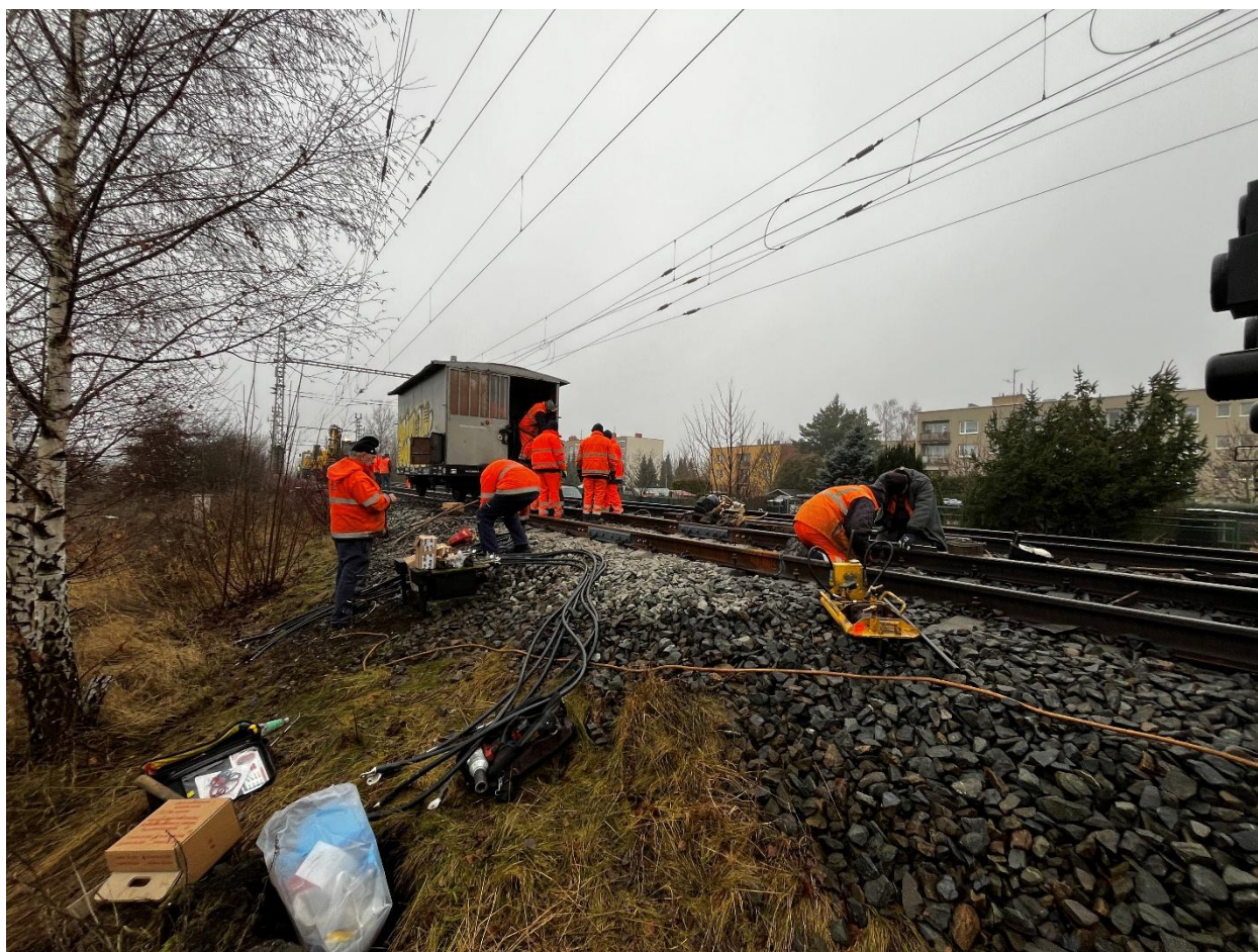
Obr. 6: Montáž SMARTLIS v trati
